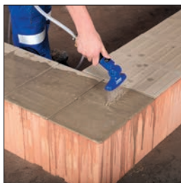
Moisten Maxit mortar pads
