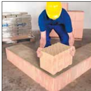
Poser la brique avec toute sa surface
