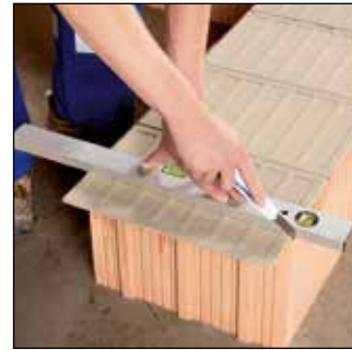
Au besoin découper les plaquettes à mortier de maxit
