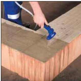
Humidifier les plaquettes à mortier de maxit
