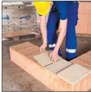
Poser les plaquettes à mortier de maxit
