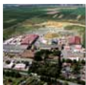
Photographie aérienne Centrale Wöllstein
