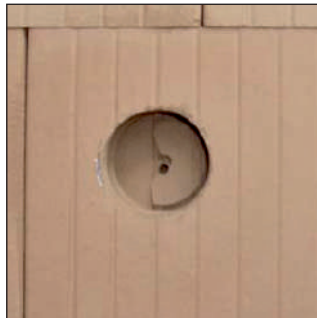
Evtl. Ziegelreste und Bohrmehl entfernen - fertig ist ein perfektes Loch für eine Elektrodose.
