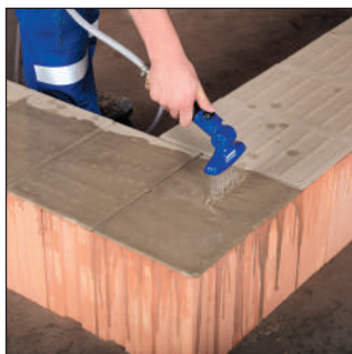
maxit Mörtelpads befeuchten
