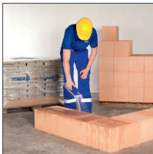
Mauersteine befeuchten
