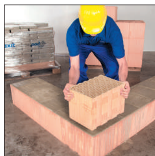
Mauerstein vollflächig auflegen
