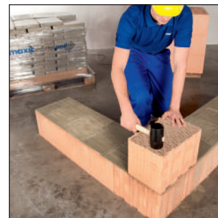
Mauerstein wie gewohnt ausrichten. Fertig!
