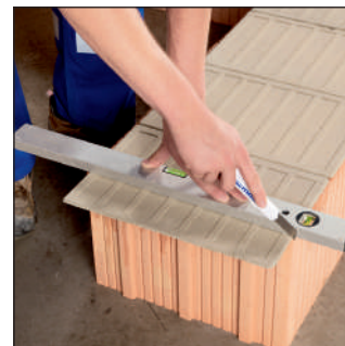
maxit mörtelpads bei Bedarf zuschneiden
