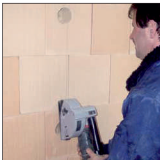
Schlitzten der Ziegel mit der Schlitzfräse.
