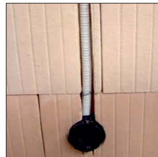
Einlegen der Elektroinstallation in die Schlitzte.
