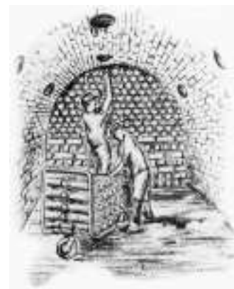
Arbeiten im Ringofen, 1860.
