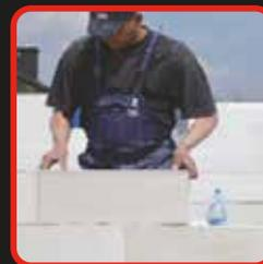
**MAX PRO 97 STONE-FIX FAST** is een vochtuithardende 1-component PU-lijm waarvan het gebruik toegestaan is in combinatie met alle maatvastе geslepen keramische lijmblokken, blokken uit cellenbeton, kalkzandsteen en gipsbeton die geschikt zijn voor het opbouwen van dragende en niet-dragende muren en waarvan de keramische blokken deel uitmaken van de technische proeven uitgevoerd in maart 2022 door het Labo Magnel-Vandepitte van de UGent.
