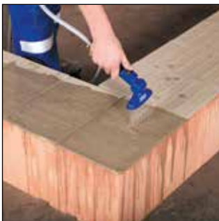
Moisten maxit mortar pads
