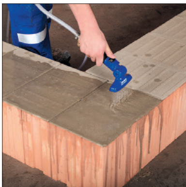
Moisten Maxit mortar pads
